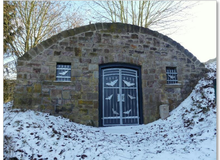
Der zum Fledermausquartier umgestaltete ehemalige Hochbehälter. Foto Sabine Tinz
