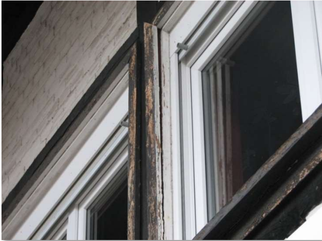
Foto 1: Winterquartier Fensterlaibung / Feldatal
