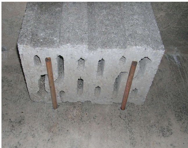
Einfache Herstellung eines Spaltenquartieres in einem Bunkerraum
