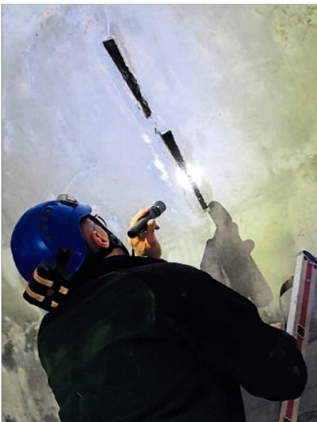
In dieser Spalte hat Harald Auth elf Mopsfledermäuse gefunden. Möglicherweise befinden sich dahinter noch mehr.
