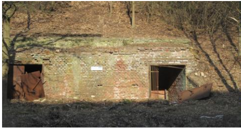
Bunkereingang vor und nach der Sanierung
