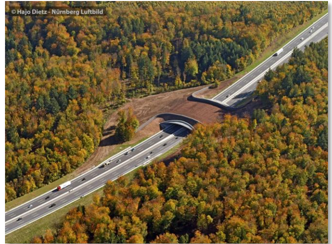
A3 Grünbrücke im Rohrbrunner Forst Oktober 2017
