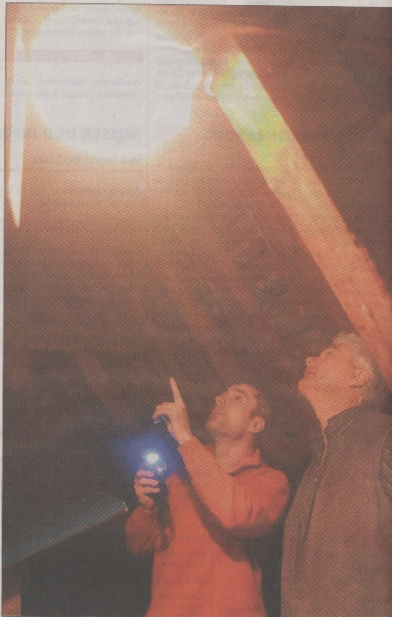
Den Flattermännern auf der Spur sind Hagen Weyrauch (links) und Jürgen Gieske auf dem Michelstädter Forstamts. FOTO: (c)
