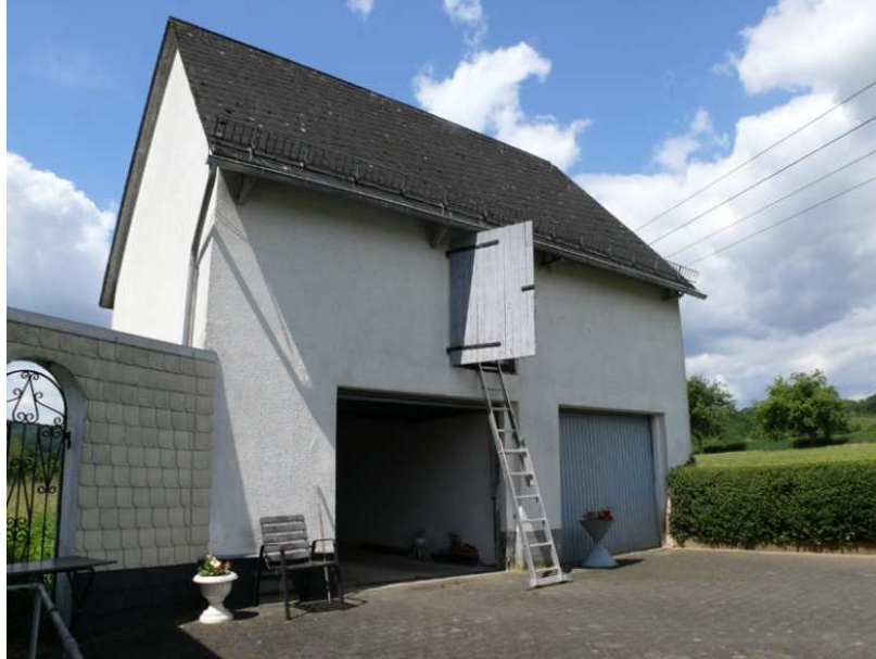
Abb. 2: Der Dachboden dieser unscheinbaren Doppelgarage in Werdorf beherbergt mit rund 1.600 Weibchen die größte Mausohrkolonie Hessens. Die Luke bildet den einzigen Zugang zum Dachboden.
